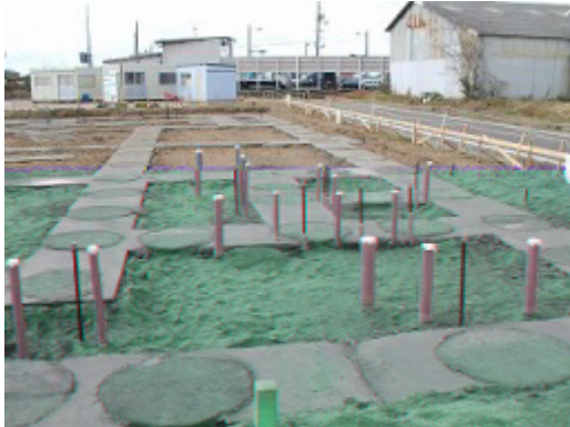
「園舎東から西を見たところ」
