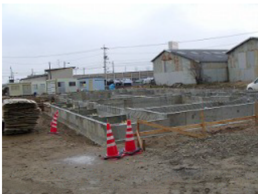
「園舎東(園庭側)から2・3・4・5歳児保育室(北)を見たところ」
